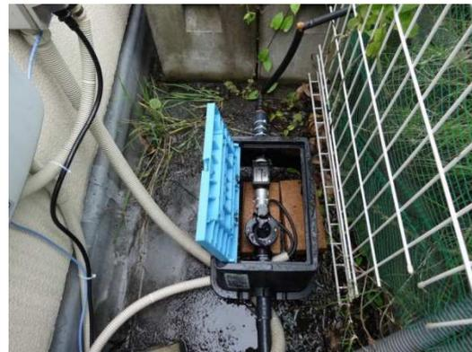
灌水電磁弁・流量センサー
